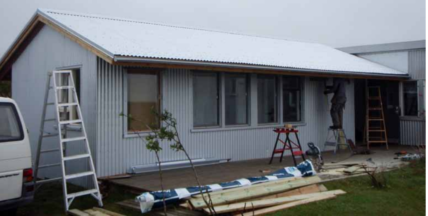
Framkvæmdir við veiðihúsið í Grenlæk/Jónskvísl á lokastigum 2012
